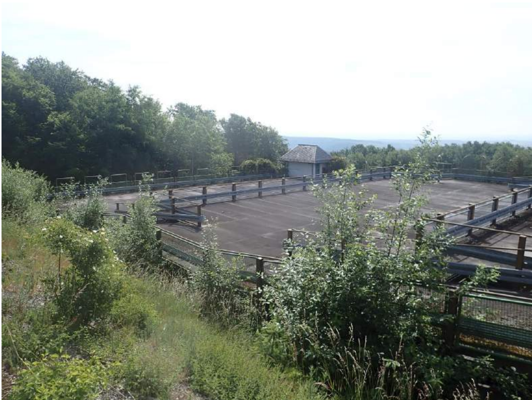
Bild 16: Ehemaliges Parkhaus im Süden mit vorgelagerter Ruderalvegetation
