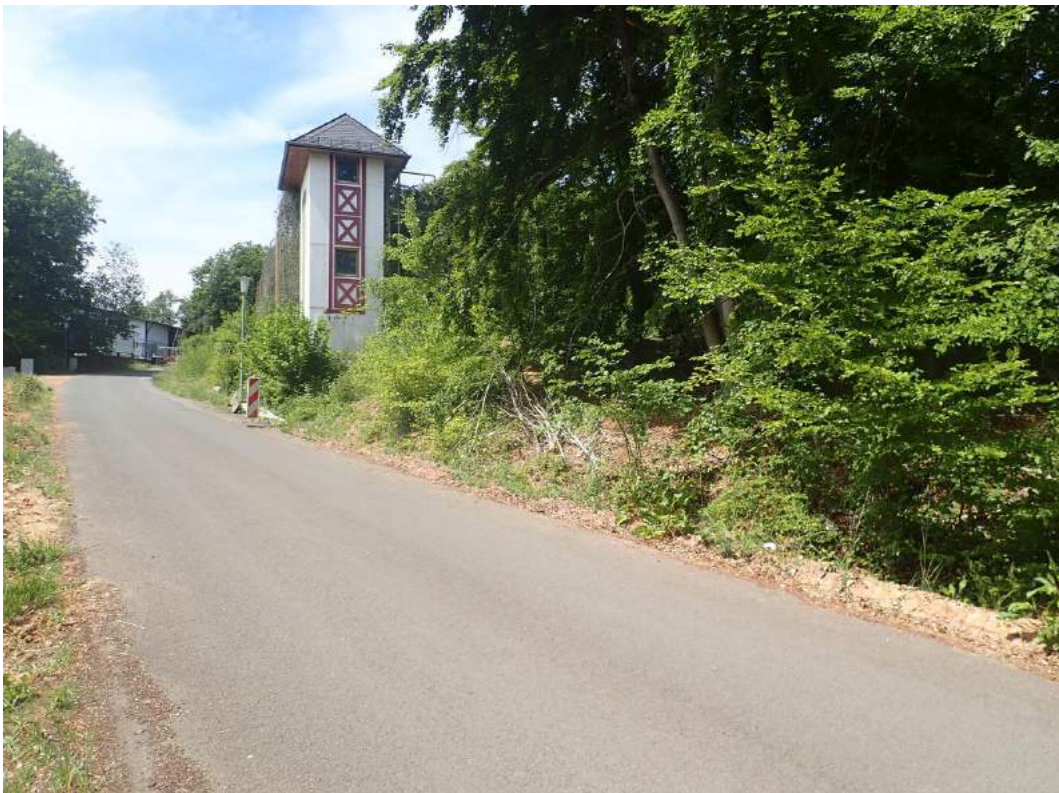
Bild 22: Südlicher Randbereich des Plangebiets
