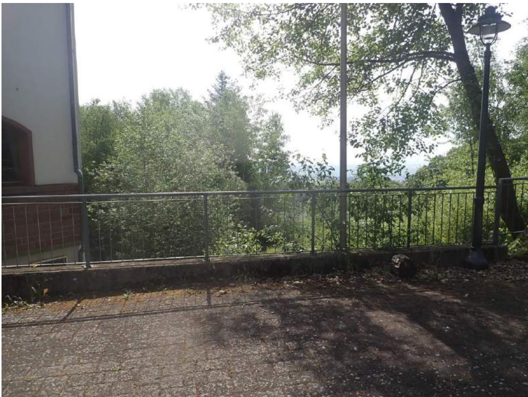
Bild 20: Blick von der Terrasse nach Süden
