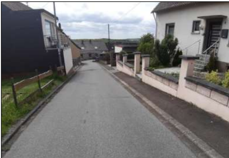
Bergstraße mit Anliegern. Die Leitwirkung der niedrigen Bordsteine ist zu gering, um das abfließende Regenwasser in der Straße zu halten. Die Anlieger müssen sich daher durch kleine Grundstücks- mauern schützen, wie hier rechts im Bild gezeigt.
