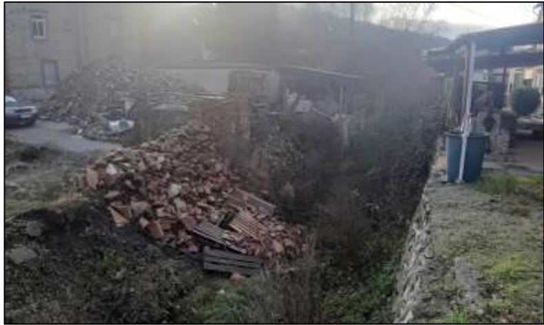
Am Ufer gelagertes Steinmaterial und Holzpaletten versperren den Fließquerschnitt
