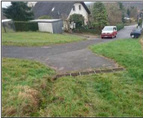
Blick auf das Einlaufgitter oberhalb der Bergstraße
