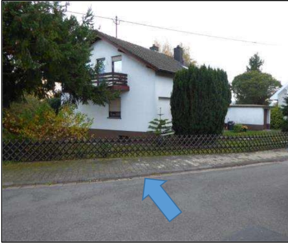
Beispiel-Gebäude an der Ecke Gartenstraße / Hochwaldstraße
