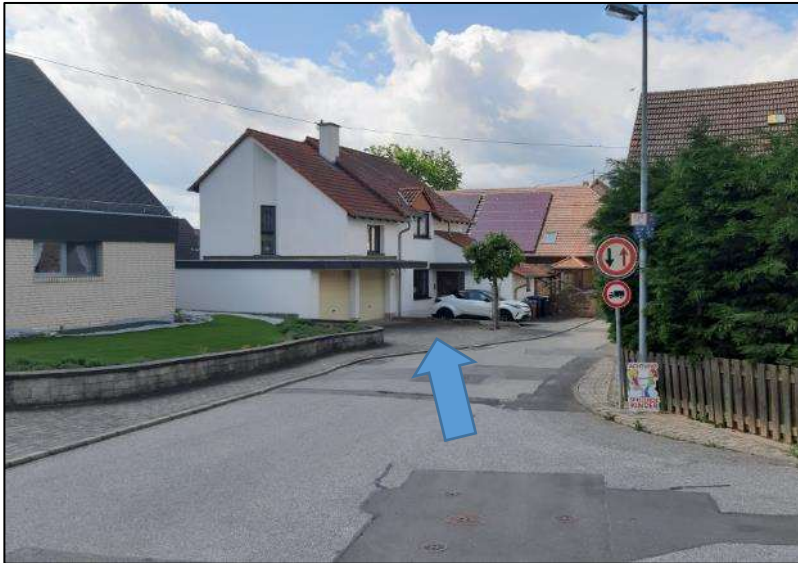
Gartenstraße mit gefährdetem Gebäude
