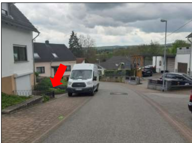
Mittlerer Abschnitt der Straße Zum Eichwald
